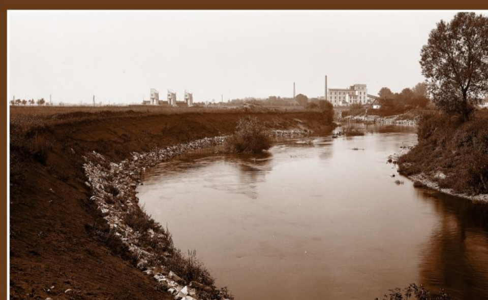
Upravené koryto Labe nad pohyblivým jezem Předměřice, 1918
