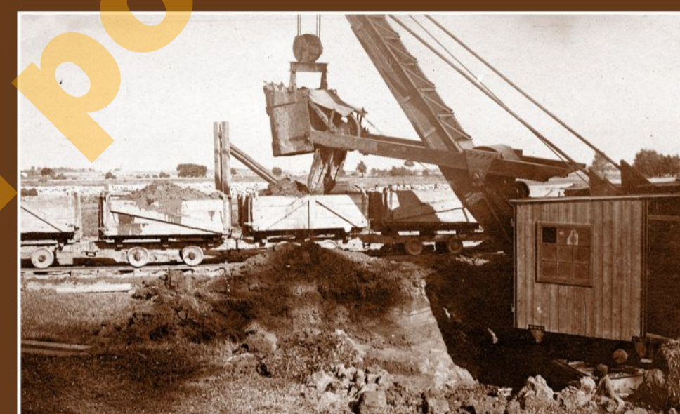
Nakládka výkopu parním „putnovým rýpadlem“, 1915
