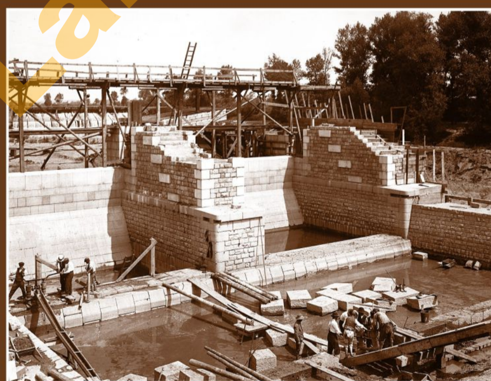
Staveniště spodní stavby jezu, 1914
