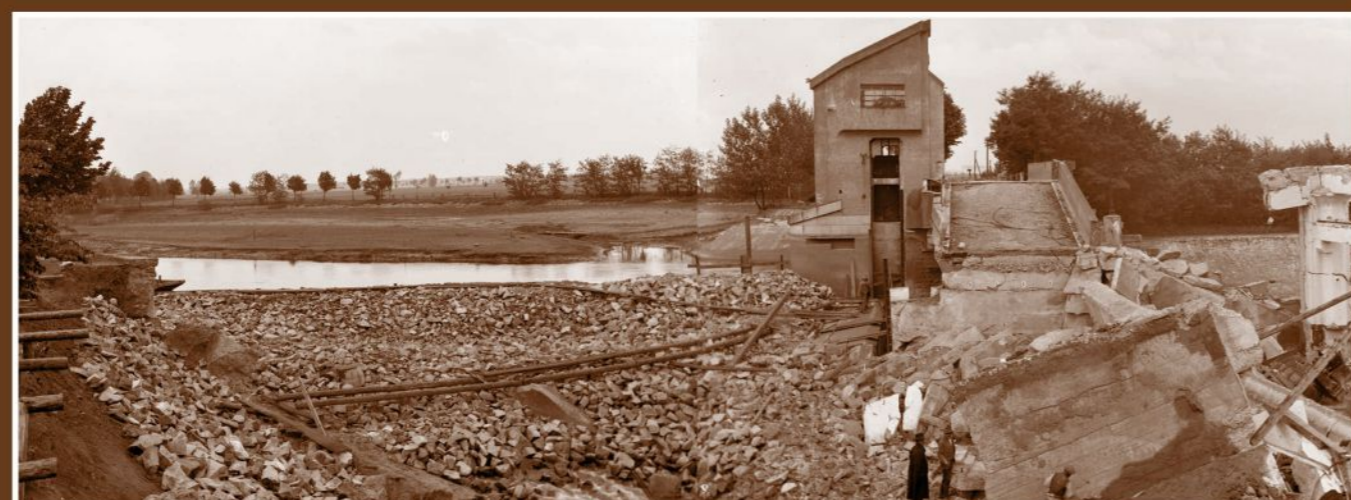
Sanace porušené části jezu a vodní elektrárny, 22. 7. 1932
