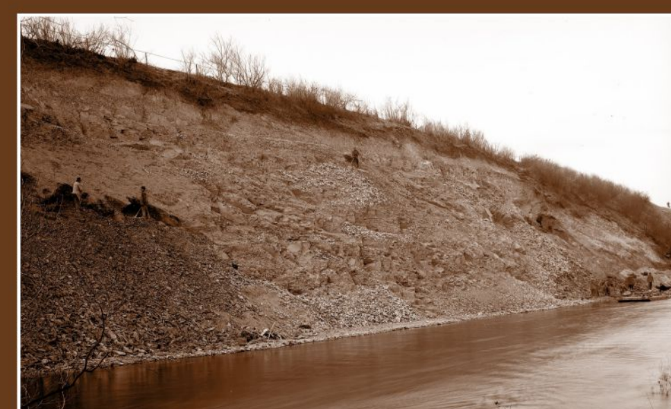
Těžba záhozového kamene v opukovém lomu u Skaličky, 1921
