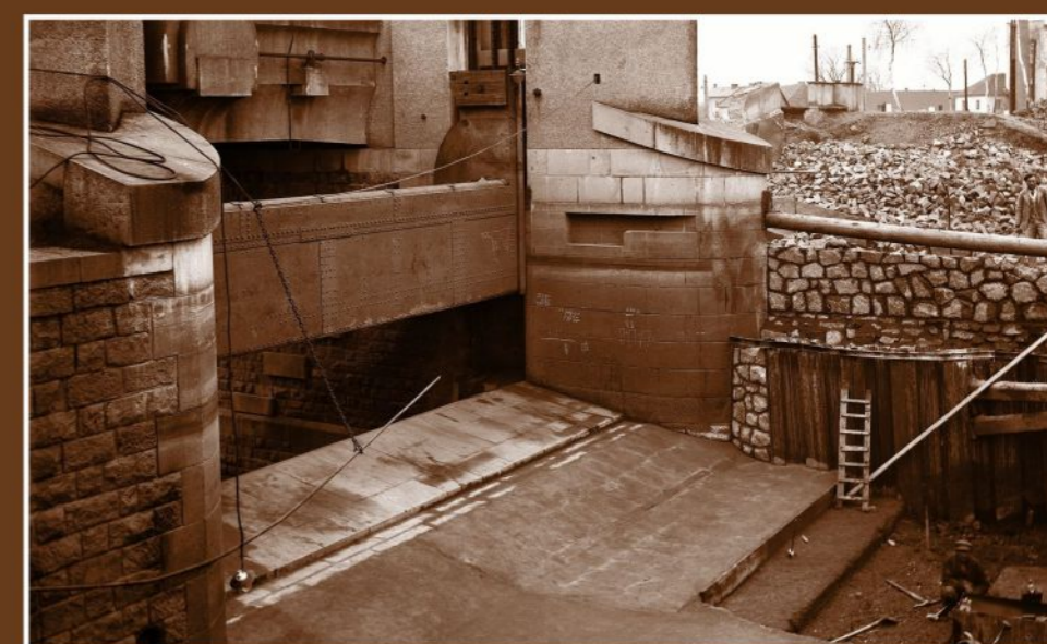
Zabezpečení levého jezového pole betonovou deskou, 1. 12. 1932
