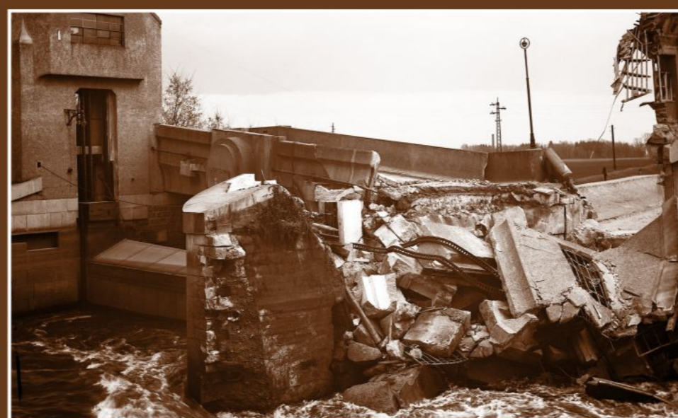
Pravobřežní jezový pilíř, 20. 4. 1932
