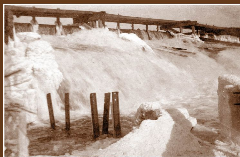
Pevný jez těsně před zřícením, leden 1918
