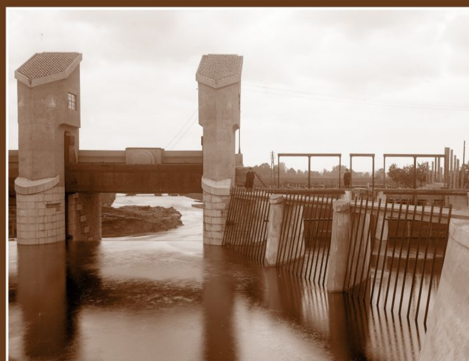
Česle před vtokem budoucí vodní elektrárny, 1918
