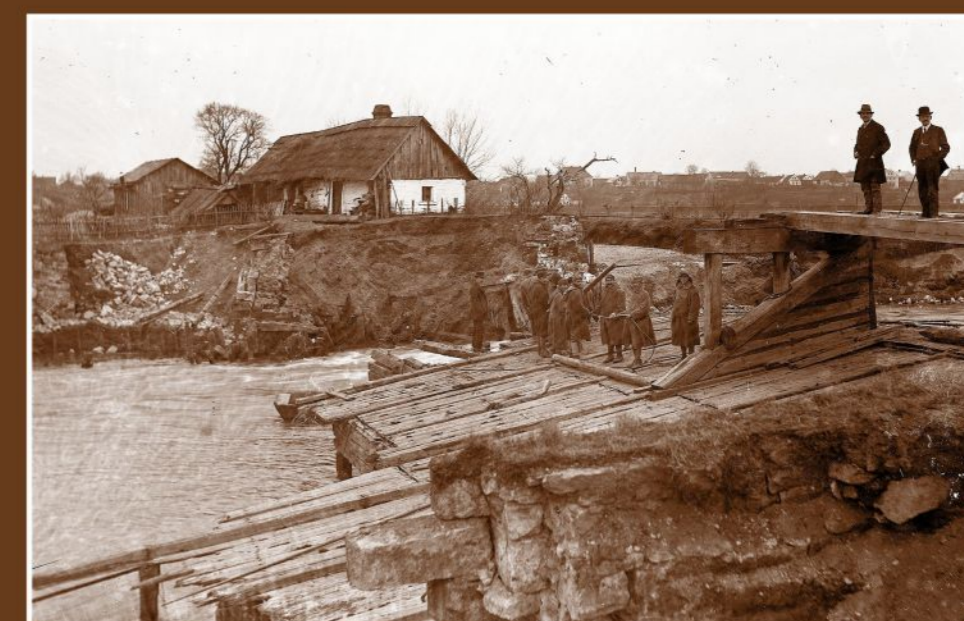
Zajišťovací práce na zříceném jezu, 5. 5. 1918
