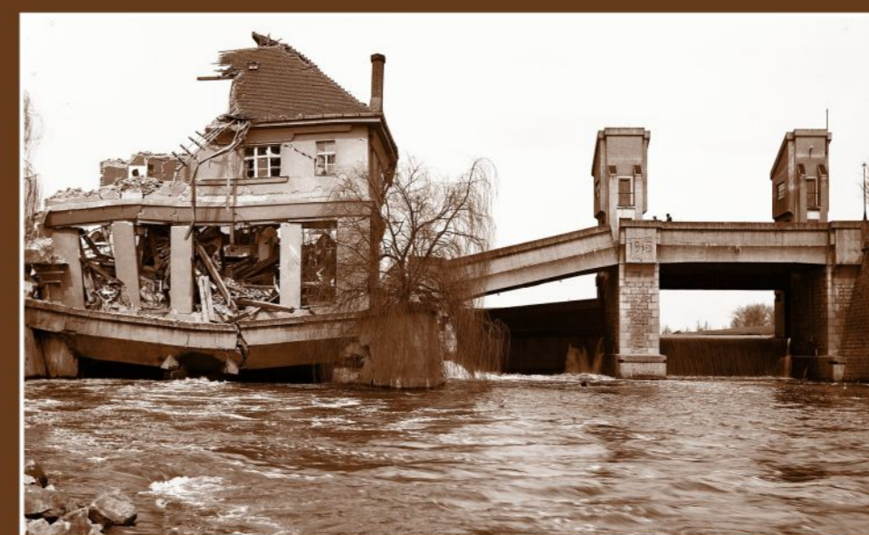
Zřícená vodní elektrárna a pravá část jezu, 11. 4. 1932
